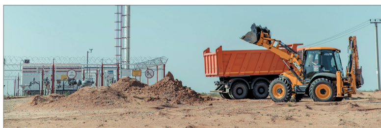
➤ Техника «Нижневожского УТТ» работает на газопроводе «Точка выхода на берег — ООО «Ставролен».
