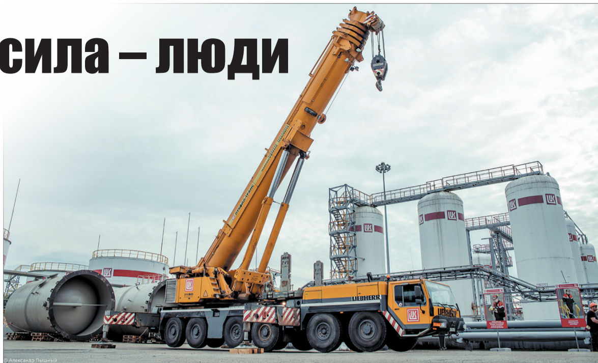
➤ Трехсоттонный кран-гигант ОАО «Пермского транспортного предприятия» работает на площадке ООО «ЛУКОЙЛ-Пермнефтеоргсинтез».
