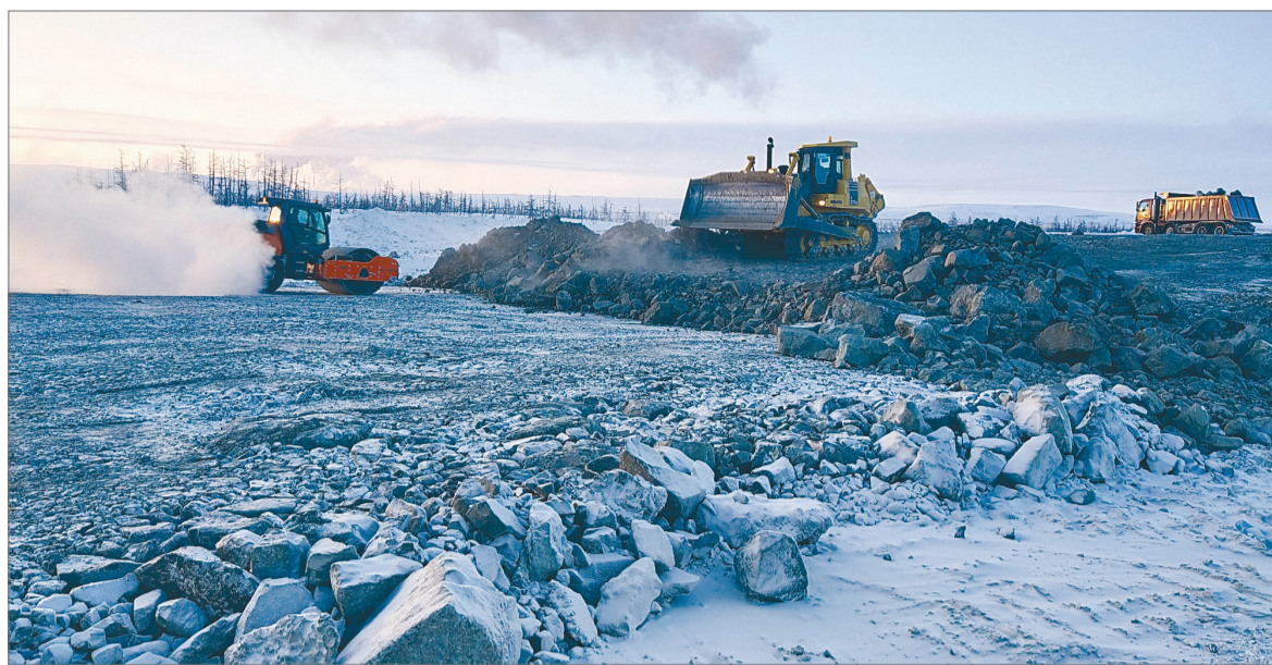
➤ Дорожники «Спецнефтетранса» на строительстве третьего поля хвостохранилища «Лебяжье» Норильской обогатительной фабрики.
