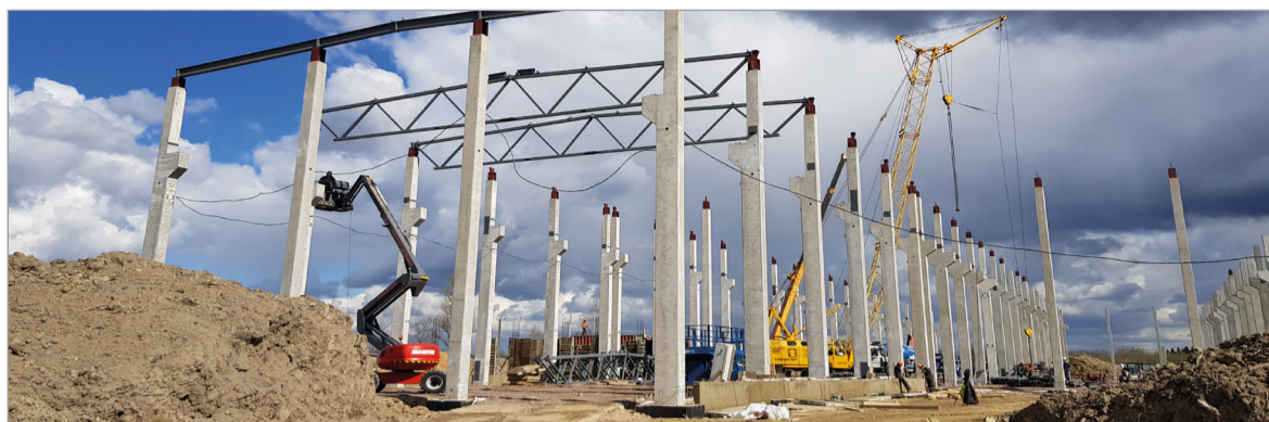
Строительство нового завода ЗАО «Капри» (г. Никольское, Ленинградская область), несмотря на ограничения по коронавирусу, идет по графику. Опоры будущего здания производственного цеха установлены, скоро планируется начать обшивать их сэндвич-панелями. Фото предоставлено А. В. Евдокимовым.
