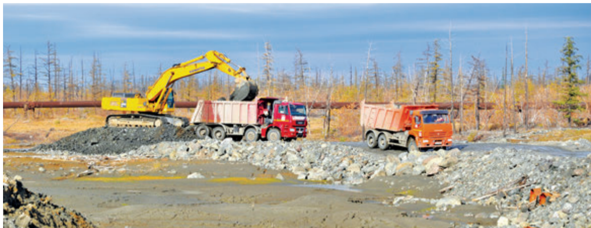
➤ Одним из объектов работ ООО «ДТК Ямал» в г. Норильск является строительство дамбы на третьей очереди хвостохранилища «Лебяжье»
