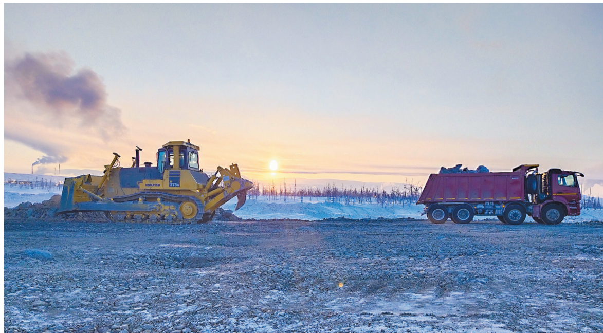
Техника «ДТК Ямал» ведёт отсыпку скальником на хвостохранилище «Лебяжье».
