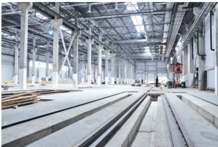
➤ Первым будет запущено в строй покрасочное оборудование, смонтированное в пролете №3.
