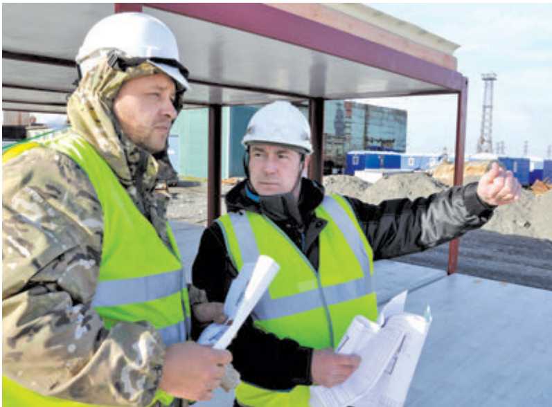
➤ Начальник электромонтажного участка М.Н. Митрофанов (справа) контролирует ход строительства общежития на базе «ДТК Ямал».
