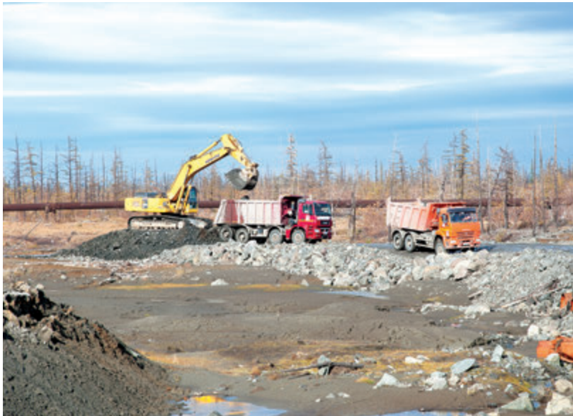
➤ Техника «ДТК Ямал» ведет демонтаж технологического проезда на «Лебяжьем».
