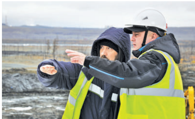
➤ Начальник норильского управления «ДТК Ямал» С.П. Комлев (справа) и производитель работ ДРСУ-2 С.С. Карасенко на строительстве дамбы на хвостохранилище «Лебяжье».
