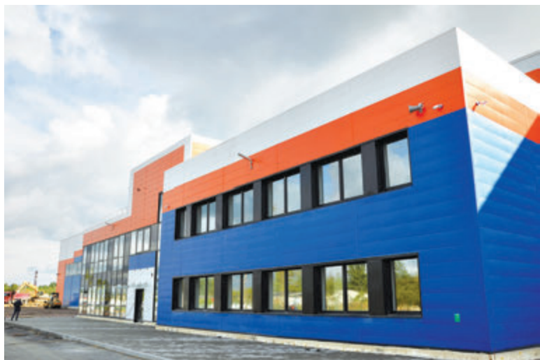
➤ АБК нового завода уже готов к новоселью.
