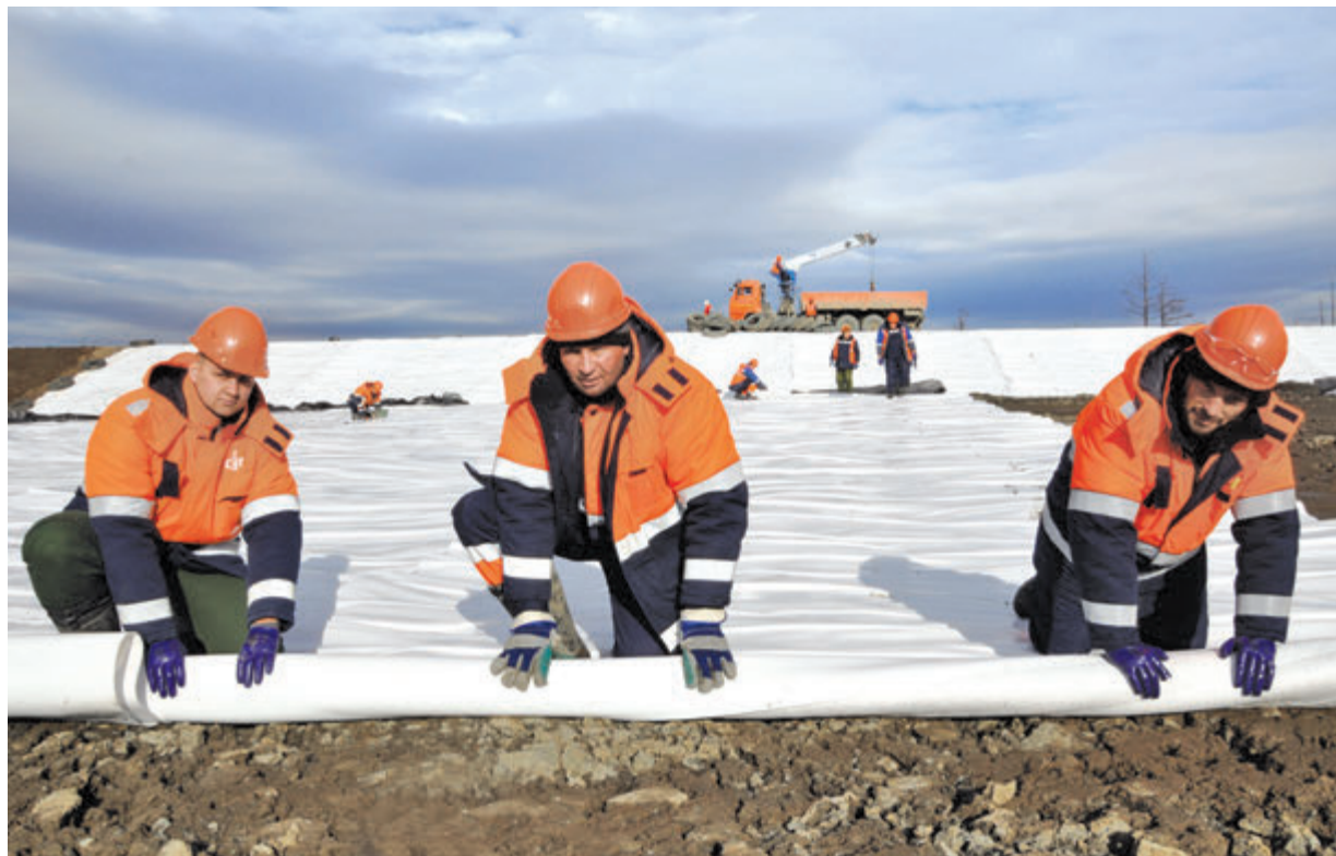
➤ 3D-гидроматы надежно защитят понур и дамбу от размыва.
