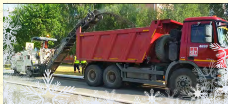
Приобретенная ООО «Нефторстрой» дорожная фреза WIRTGEN W100R была впервые использована при ремонте ул. Ленина в г. Урай.
