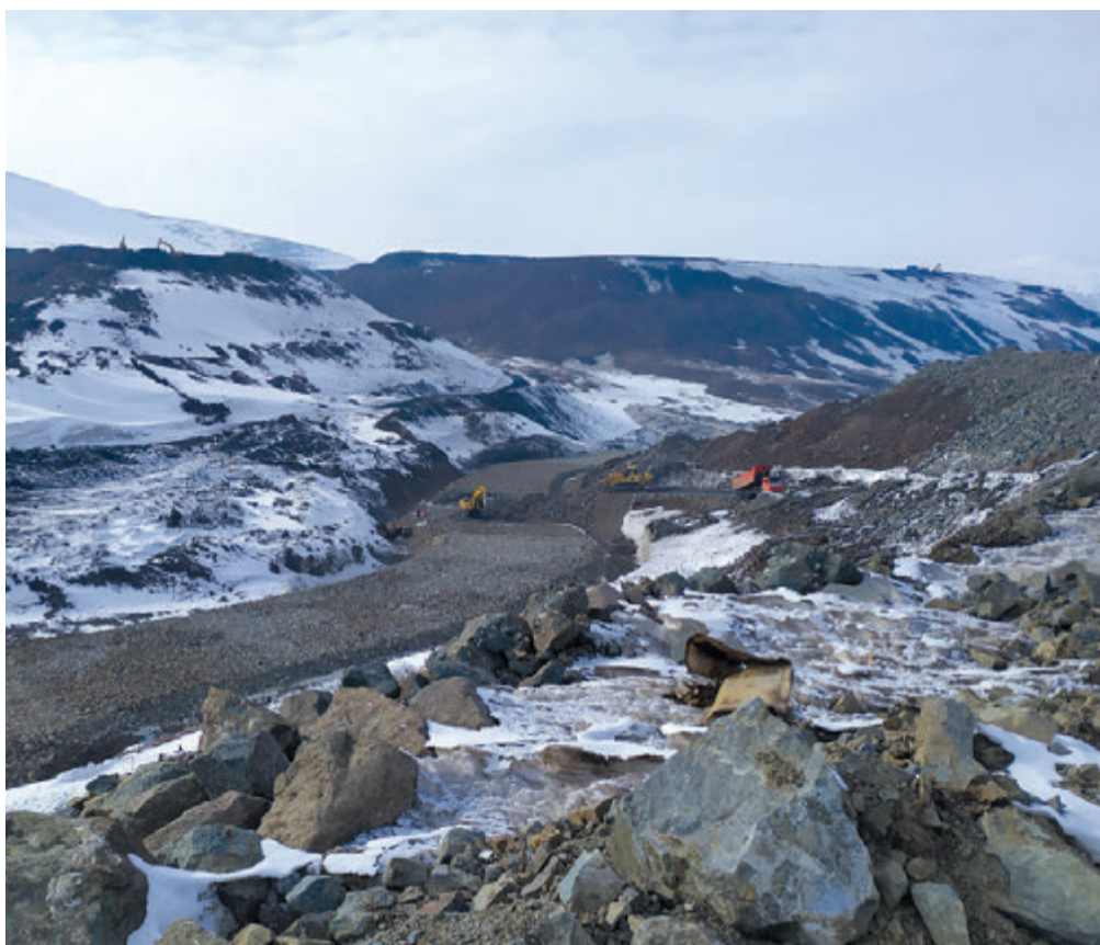
➤ Строительство фильтрующей насыпи на Черногорском месторождении
