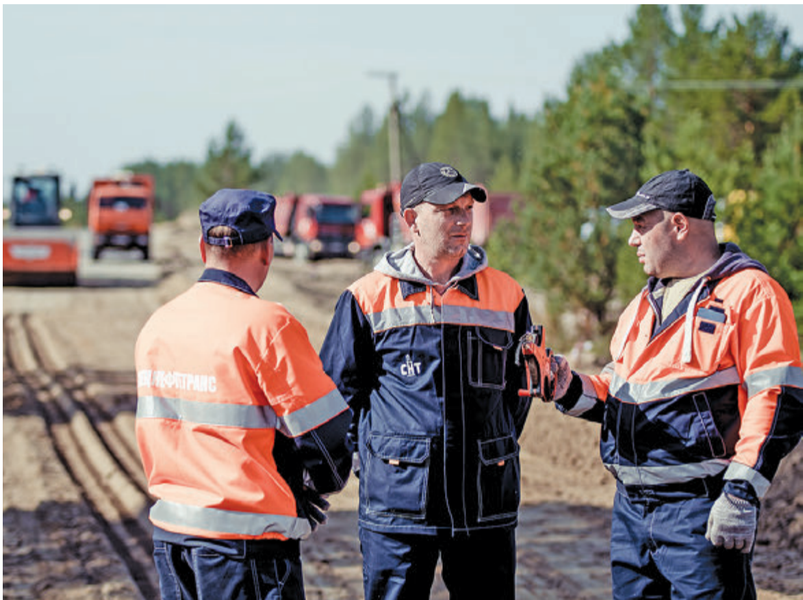
➤ Строительство дороги ведут работники ООО «Нефтедорстрой»
