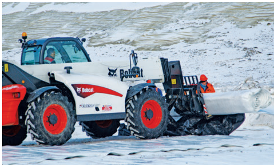
Укладка гидроматов на хвостохранилище «Лебяжье»
